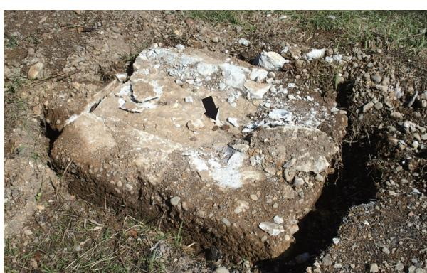
写3.3.3.3 門柱基礎 鉄製太柄のひとつを矢印で示す。もうひとつは門柱基礎に取り付いた状態で保存した。
