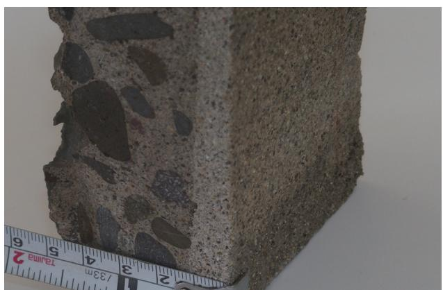
写3.3.1.4 腰壁内側断面 板材型枠の痕跡 (制水井2号上屋)
