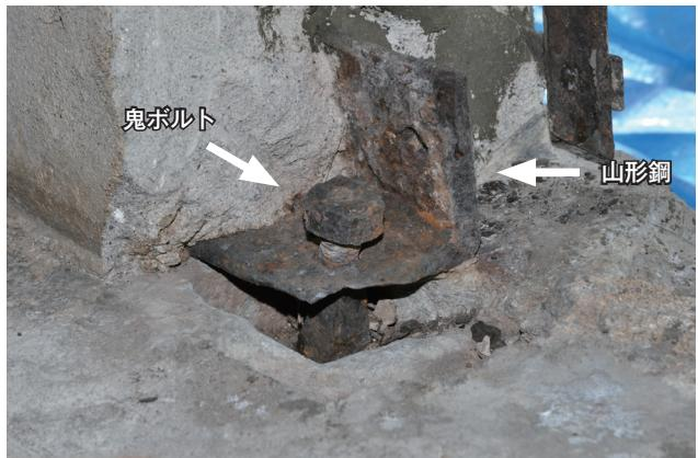
写3.3.1.2 土台山形鋼と鬼ボルト (制水井3号上屋)
