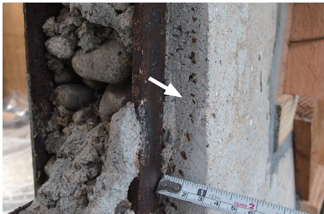
写3.3.1.3 腰壁外側断面 鉄網を型枠として利用 (制水井2号上屋)
