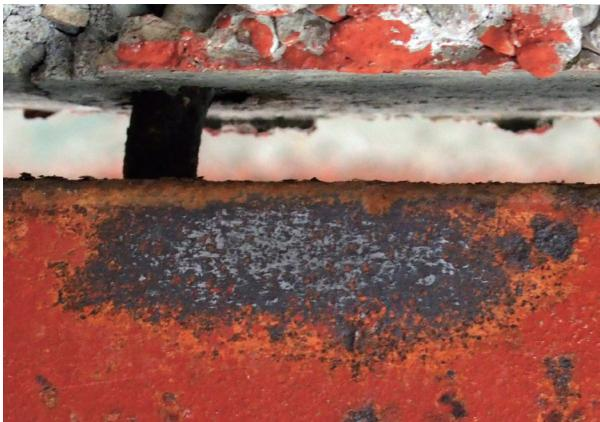
写3.3.4.9 下流側管理橋根太の塗装調査 床版への塗料付着
