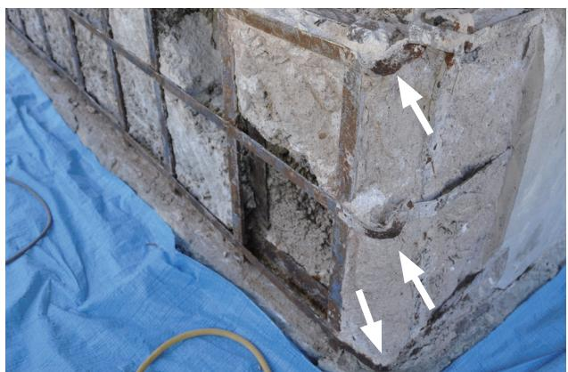
写3.3.1.6 大正7年転倒時に生じたと思われる鉄骨ゆがみ (制水井1号上屋)
