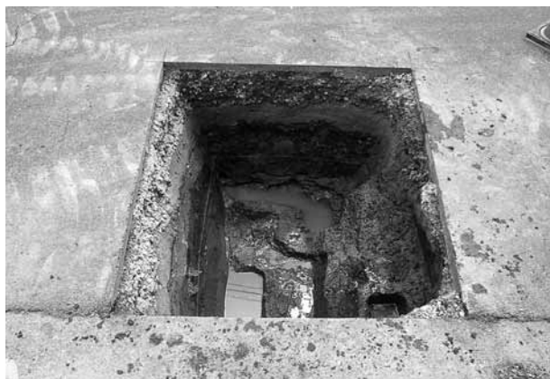
天神山遺跡第1 トレンチ掘下げ状況 (北東から)
