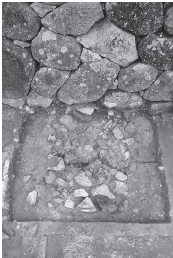
3 礎石根固1 (北西から)
