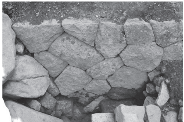
5 第3調査区 Tr-4 石垣接合部（西から）
