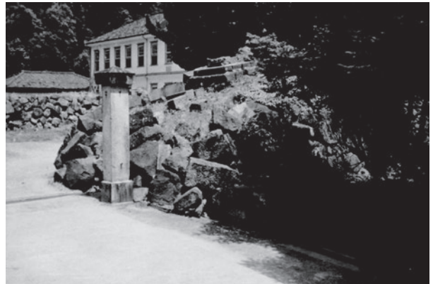
写真6 地震により崩壊した太鼓御門石垣
