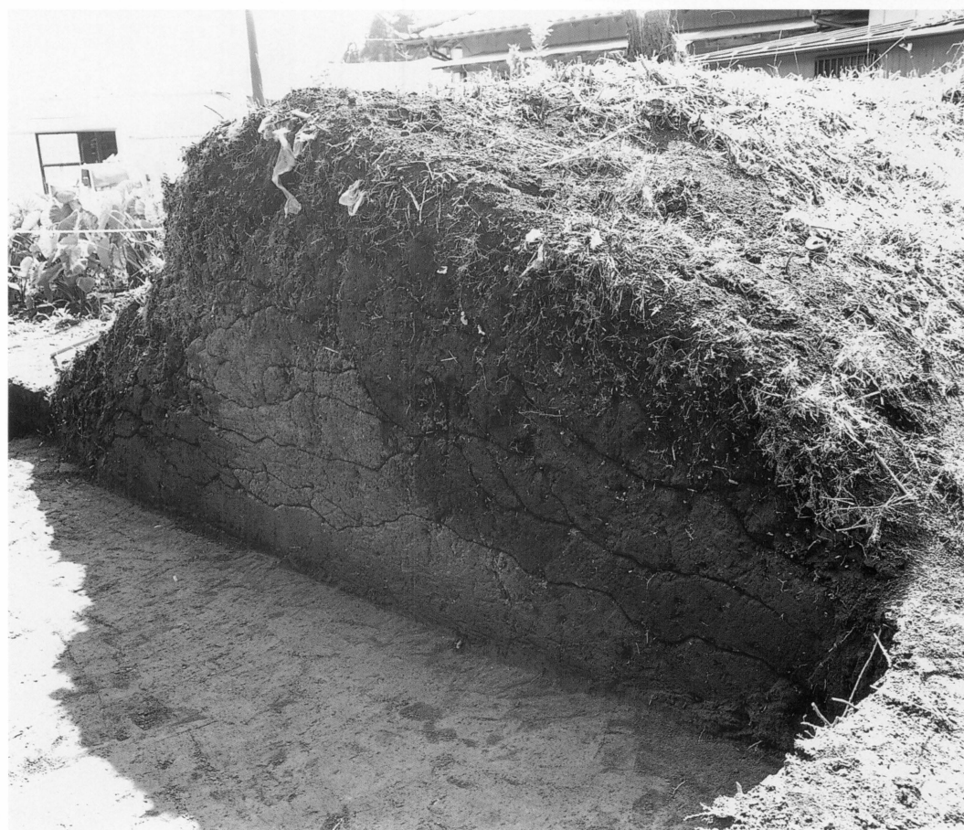
馬土手D区 トレンチセクション
