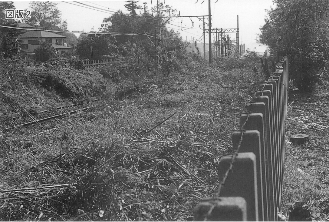
調査前近景（北から）
