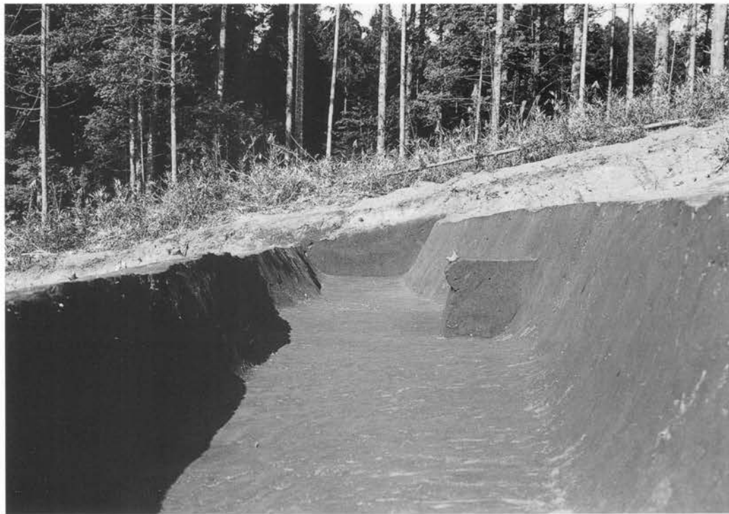
2 SD-001号近景 南から
