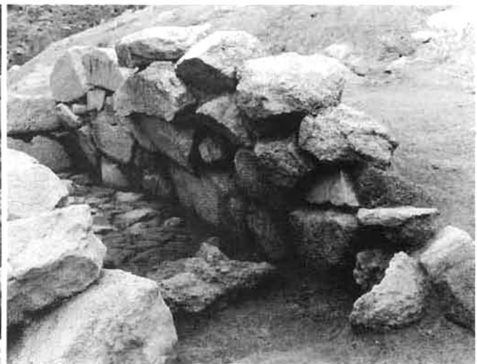
石室 左側壁 (南西から)
