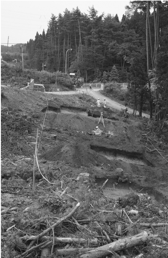
付替道路A作業風景 (N→)
