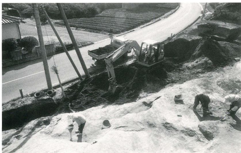
重機稼働風景
