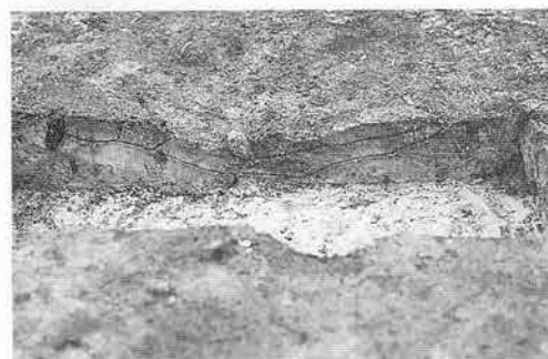
上 地床切断面(南から)
