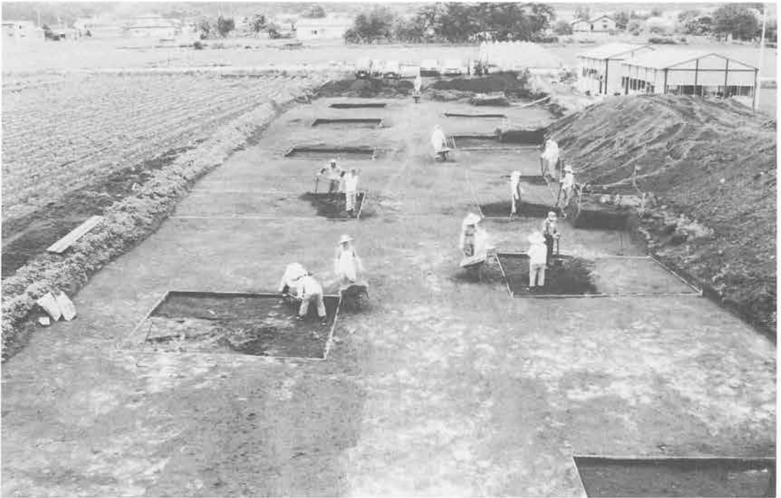
2. G II区からK II区の遺構確認 (北々西から撮影)
