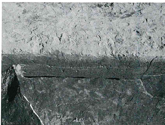
SX-01 全景 (西から)
