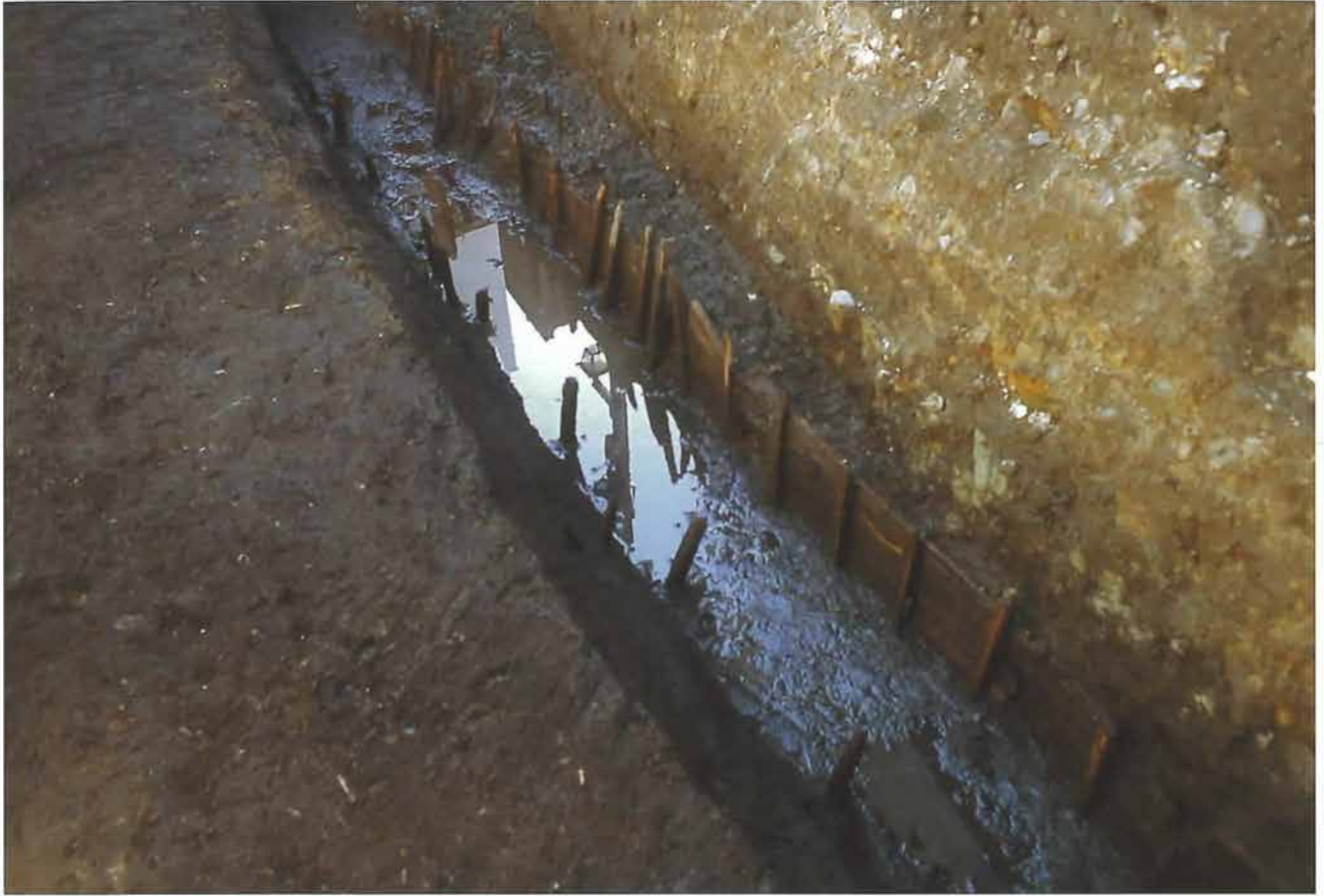
写真7 道路の側溝 (Photo 7) Gutter
