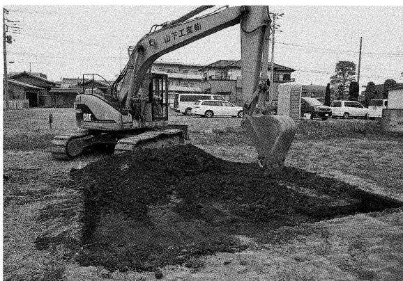
重機掘削（南より）
