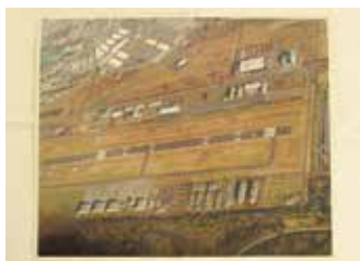
整備が進む広域防災基地の航空写真 (平成3年頃撮影、立川市蔵)
