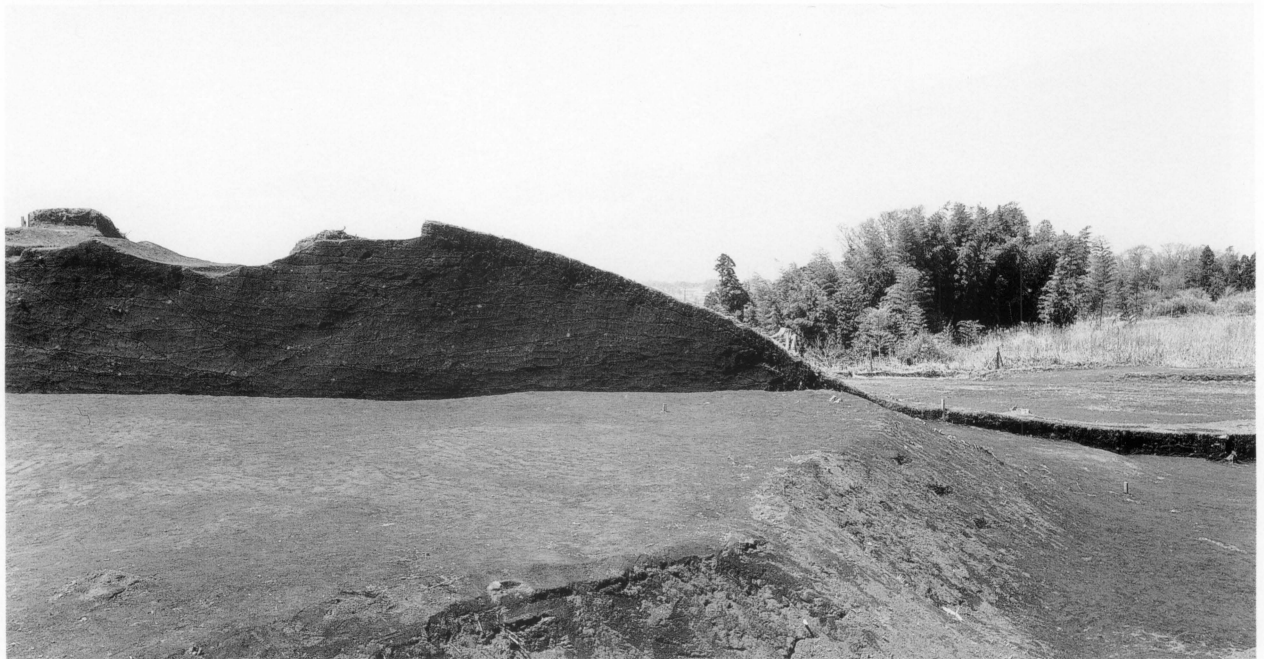
2 墳丘盛土 南北土層断面 北部分（東から）
