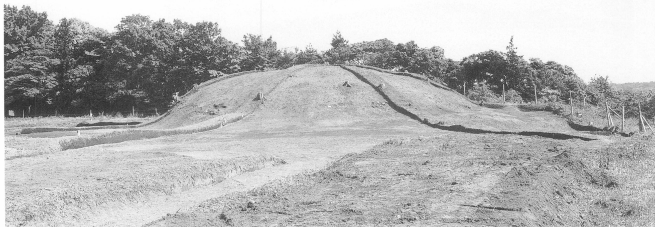
3 表土除去後近景（北西から）
