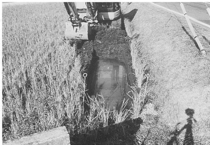
5. 3トレンチ調査風景 (南東から)
