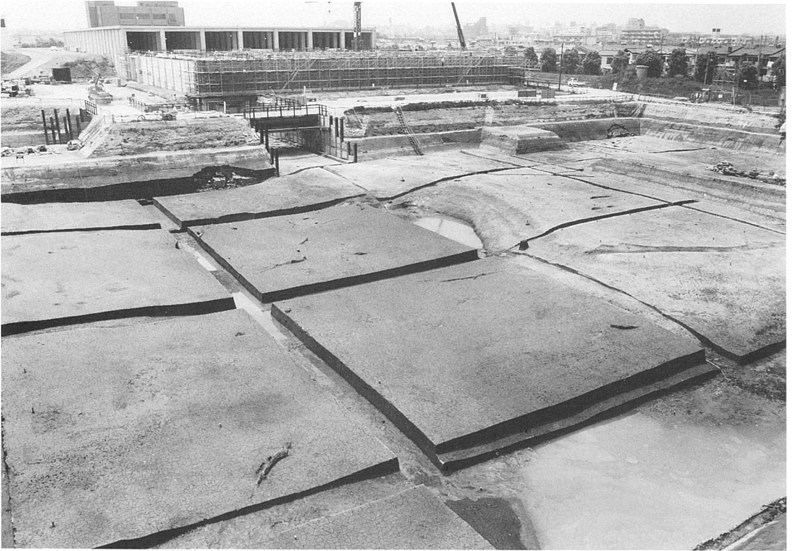
3区掘削終了状況全景（北東から）
