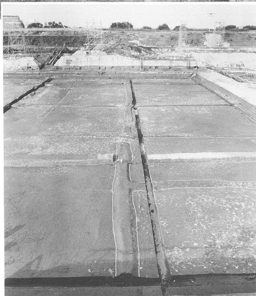
3区南北坪境畦畔（南から）
