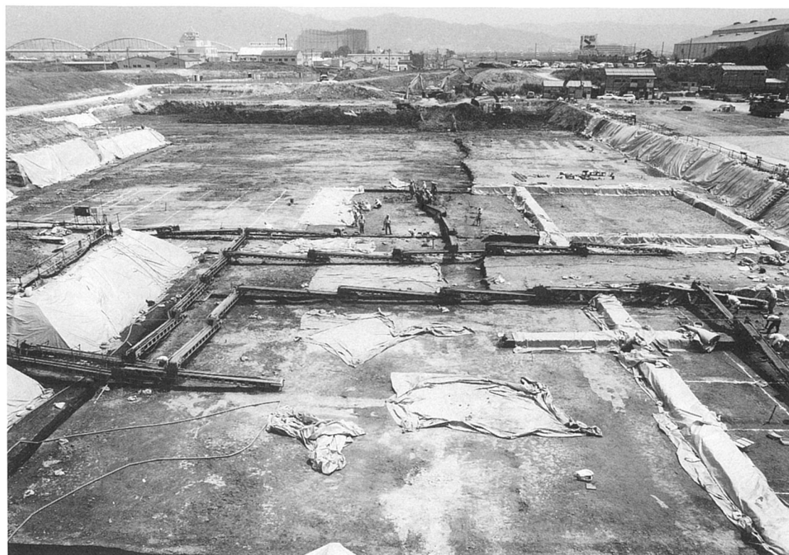
機械掘削の状況（西から）
