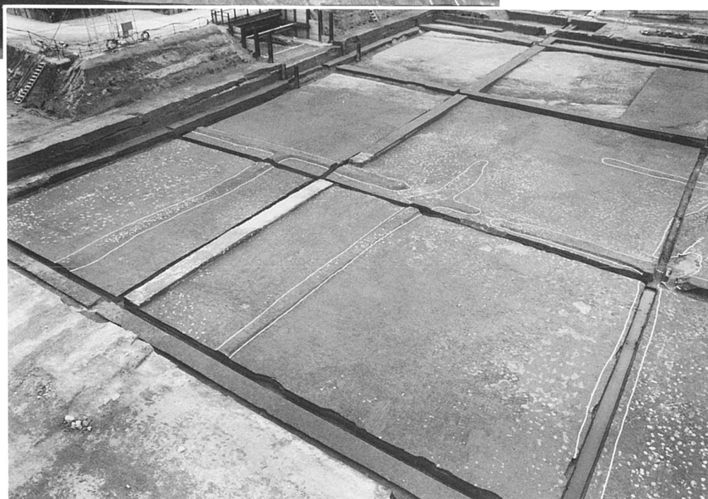
3区南半（北東から）
