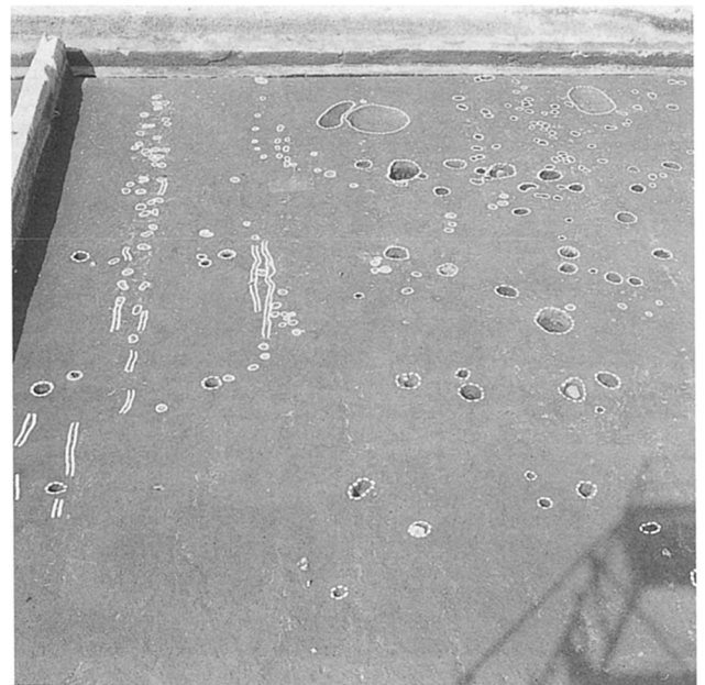
東半部 (南から)
