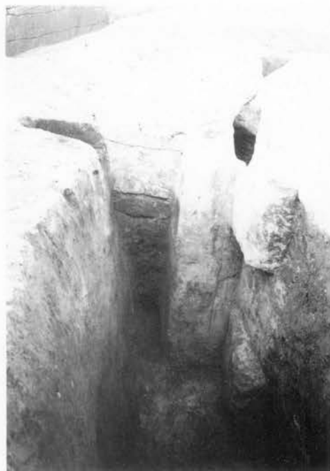
2. 奥壁背後の裏込め
