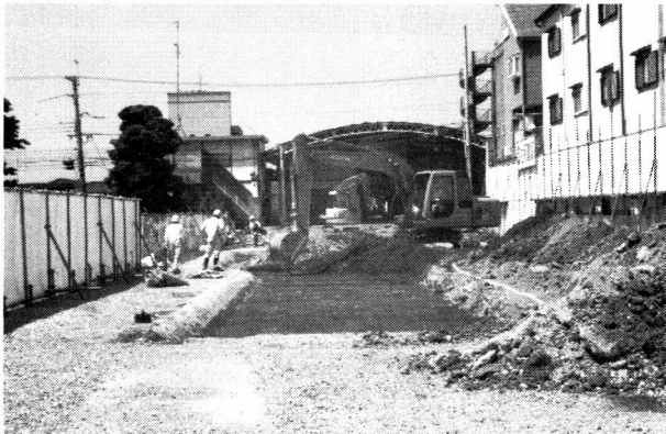
図1 機械掘削 南から
