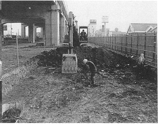
写真2 10Fトレンチ機械掘削状況
