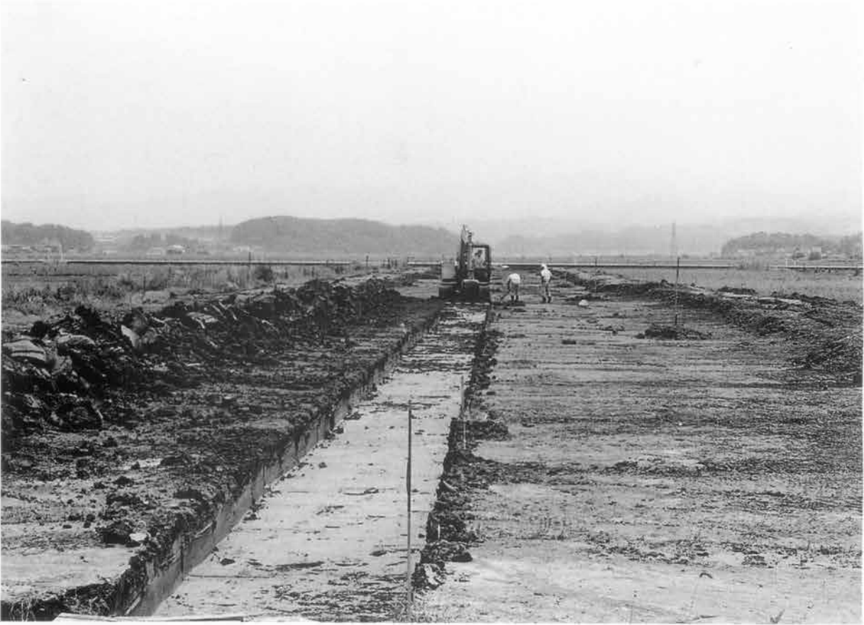
A地区上部層掘削作業（西方より）
