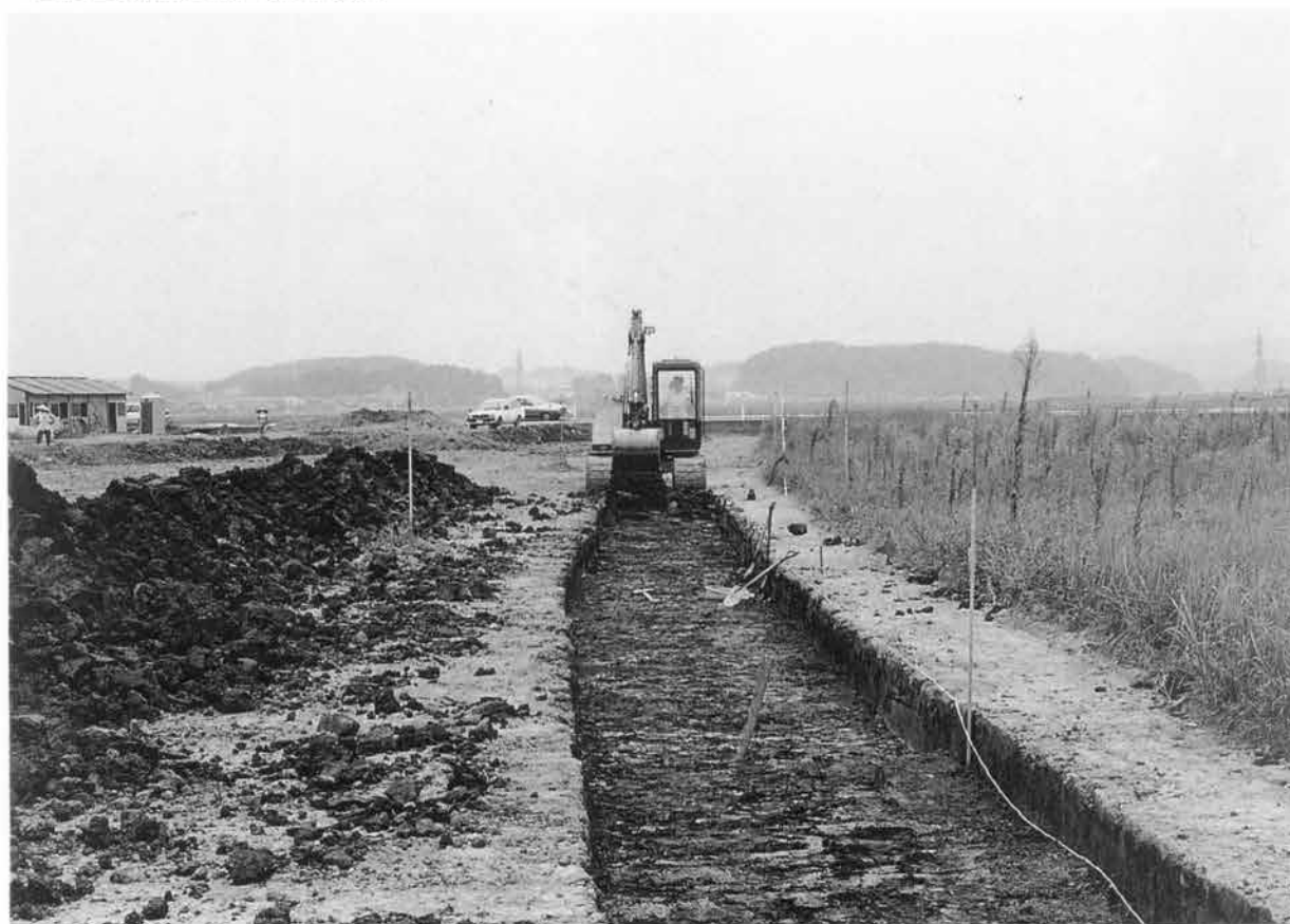
B地区上部層の掘削作業（西方より）
