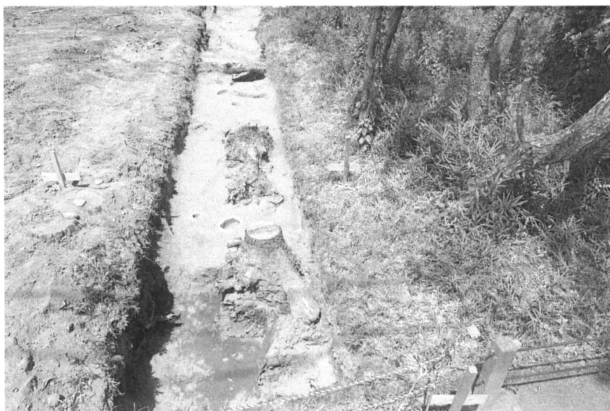
1-1区東側 全景 (南から)
