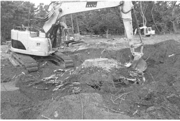
除根作業状況
