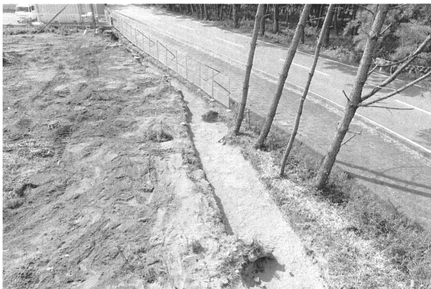
1-1区北側 全景 (西から)
