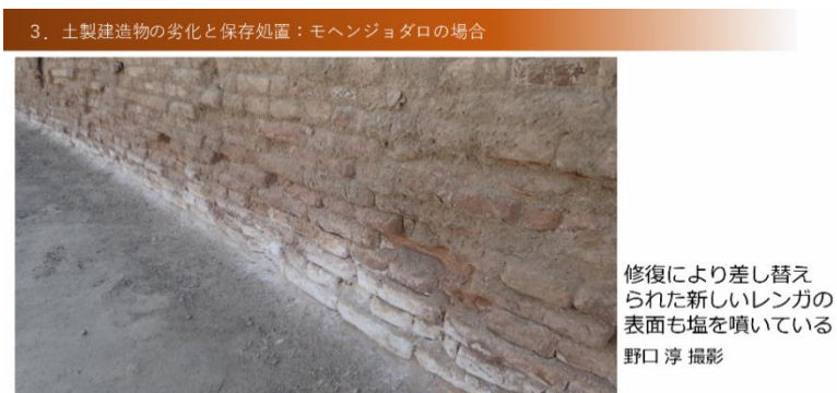
図21 モヘンジョダロの日干しレンガの塩類風化
