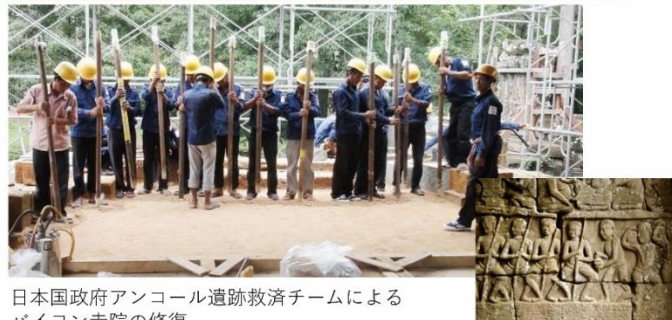
図 30 バイヨン寺院の版築による修復
