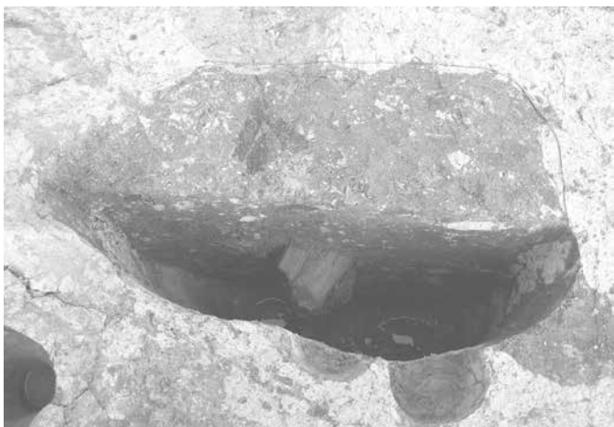
15SE900 断面 (西から)
