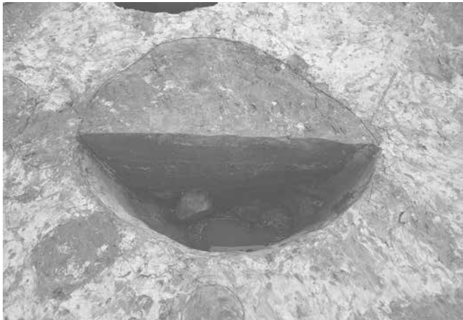
15SE2002 断面 (西から)
