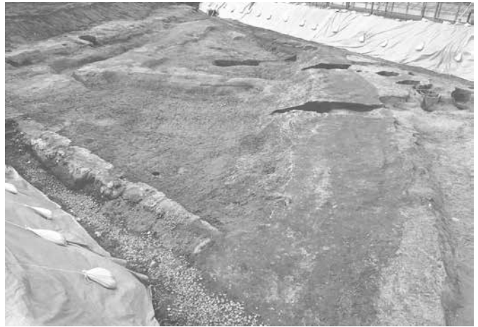
14SX1000 と盛土の様子 (南から)
