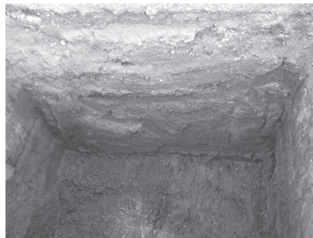
第8図版 浄化槽掘削断面
