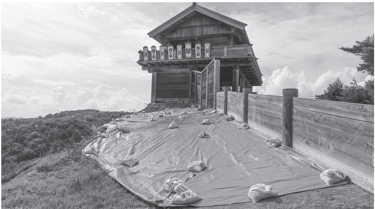
第25図版 版築土壘天端ブルーシートによる保護（東から）
