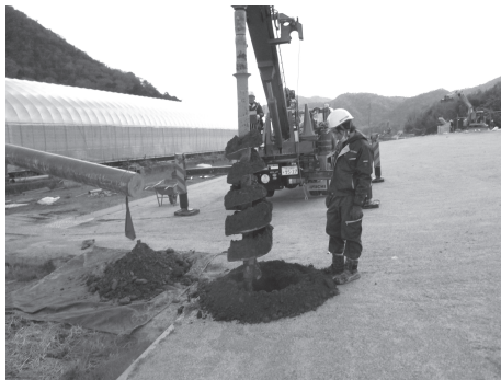
第5図版 掘削状況
