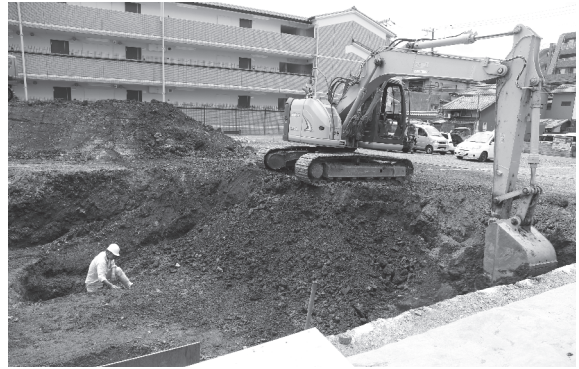
2. 重機掘削 (北東から)
