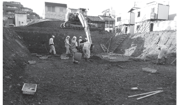
6. 3区作業風景 (北東から)
