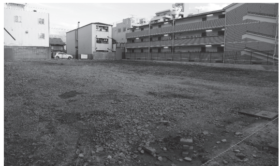
8. 調査完了後 (北西から)
