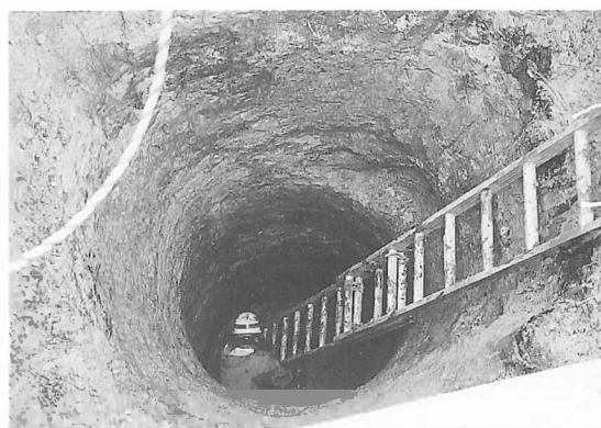
55SE1調査状況
