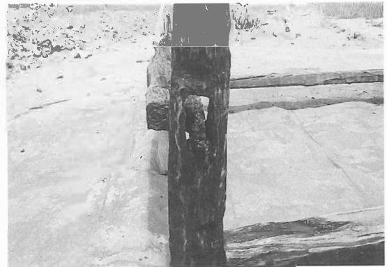
55SE1井戸枠組み立 (部分)
