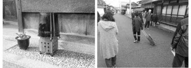
写真1 地区内の住宅前に置いてみた消火器格納箱
