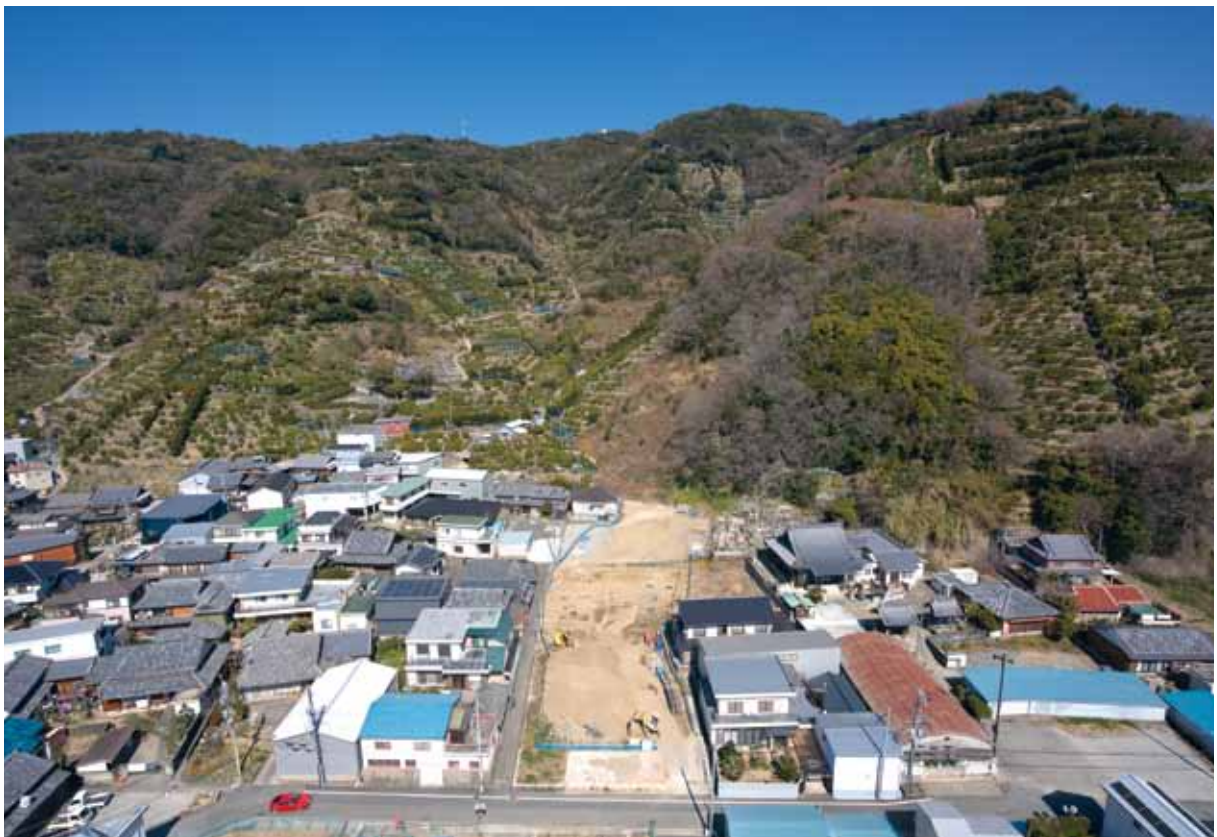
2. 調査区近景（南から）
