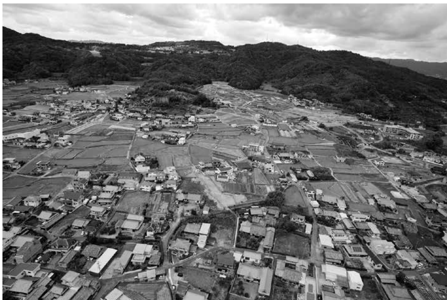
1. 調査地 全景 (南上空から)
