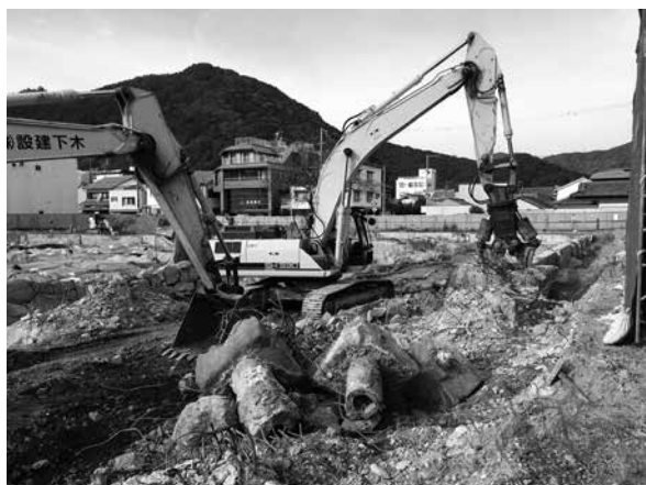
写真8 ②区校舎基礎コンクリート撤去作業風景
