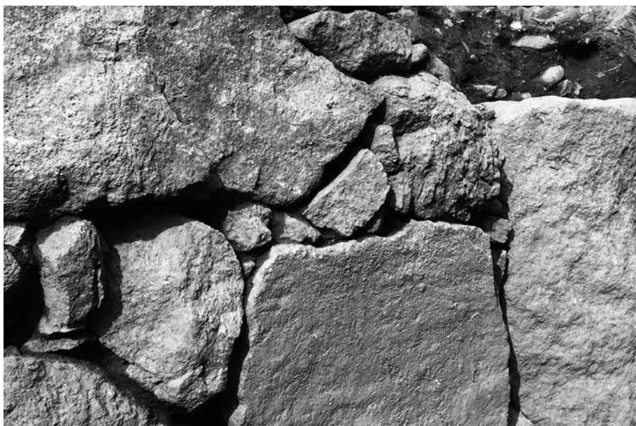
2. 遺構 201 (屋敷境の石垣) 細部 (北東から)
