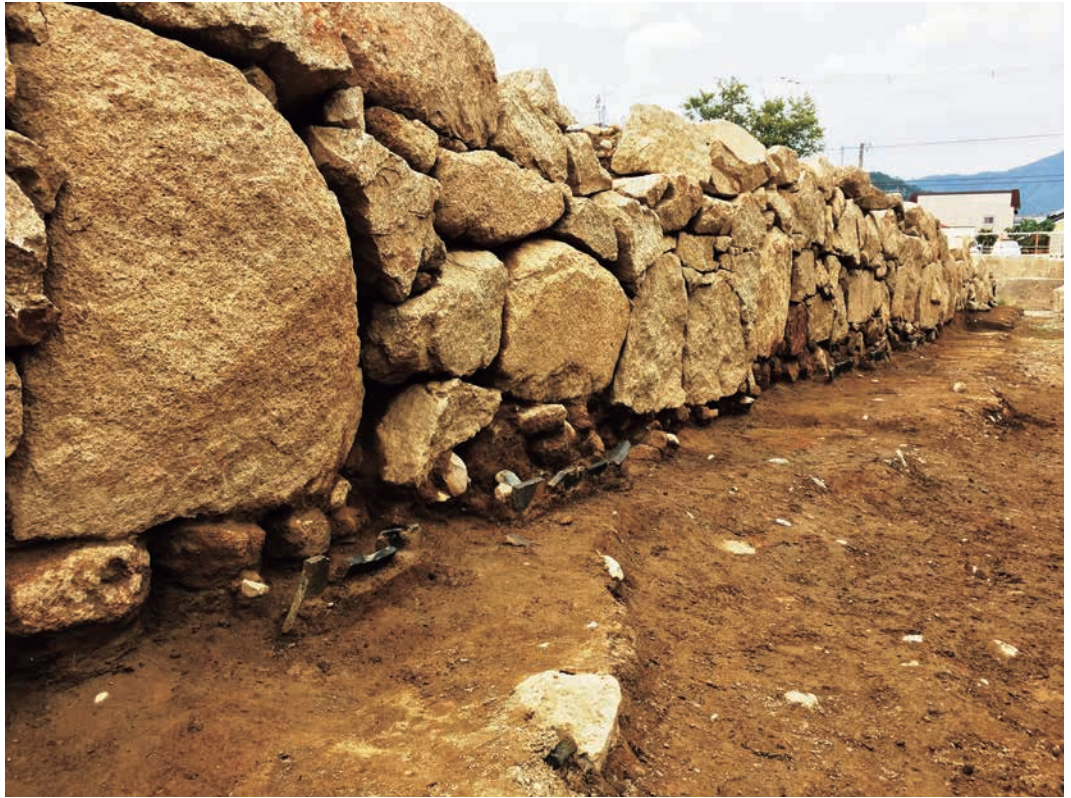
遺構 201 近世の石垣（北東から）
