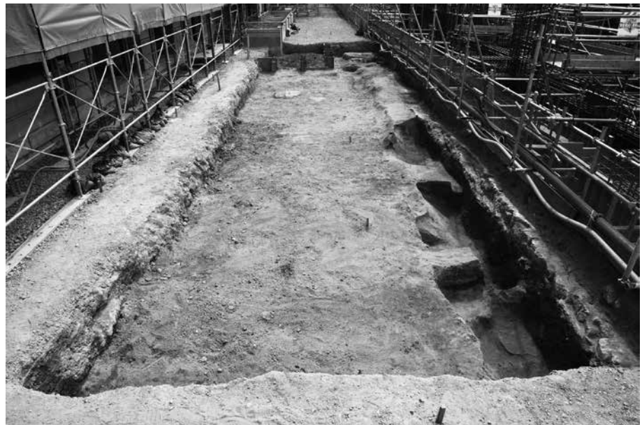
2. 5-1・2区第2遺構面 全景（西から）
