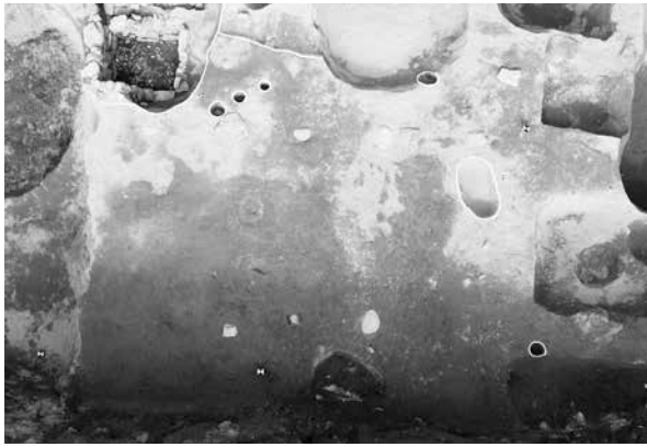
1. 1・2区 第3遺構面 礎石建物 1-A (上空から上が北)
