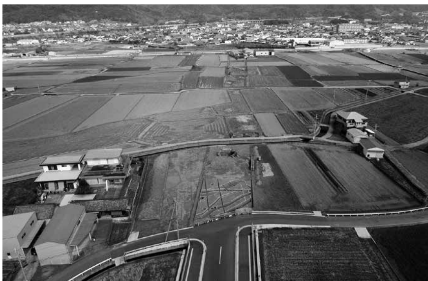
2 3-2区全景（南上空から）
