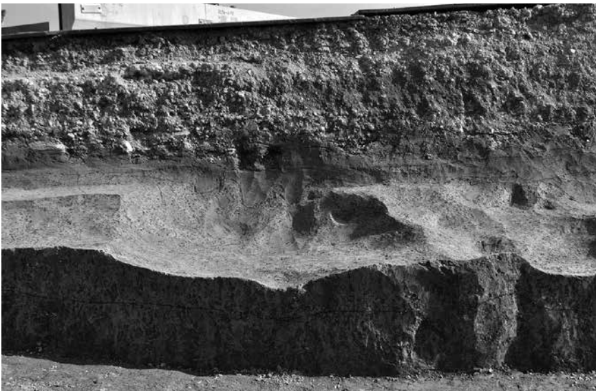
2 2-1 区南壁 (北から)
