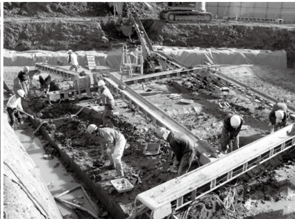
写真2 1区 1自然流路掘削状況(北西から)
