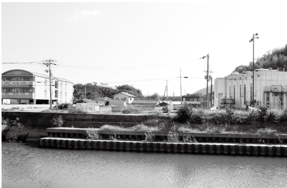
1 調査地遠景（北から）
