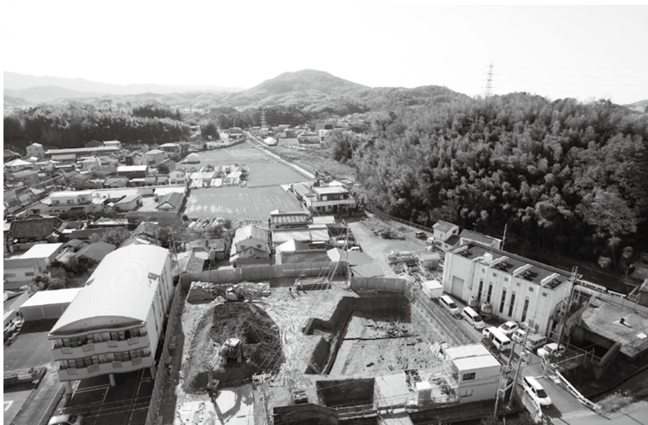
1 1-1区・1-2区 調査地と周辺部の状況（北北東上空から）
