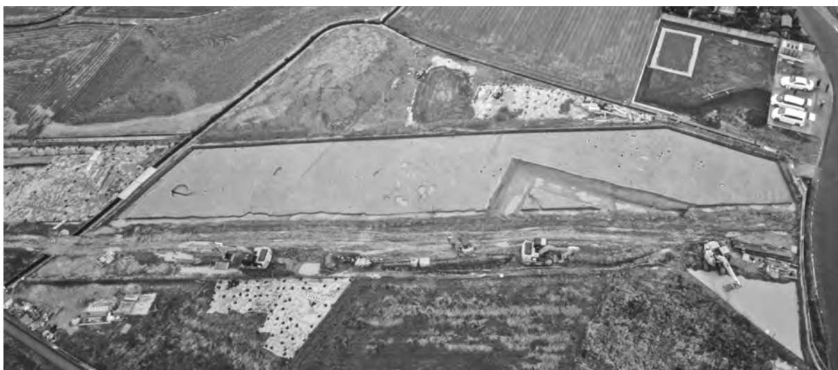
2-2区 2堀（南上空から）
