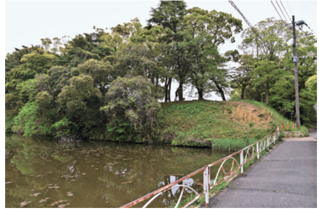
図5 潮見櫓跡（北から）
