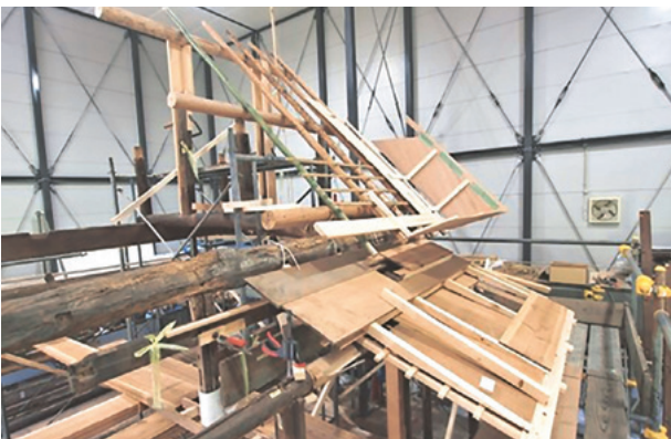
図 18 令和 3 年度仮組調査の様子
