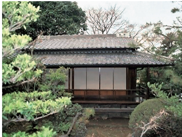
図13 余芳亭東側外観(昭和61年撮影)
