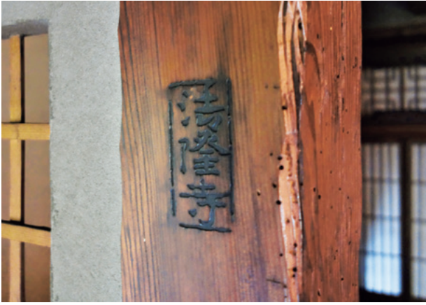
図1 N家離れの床柱
