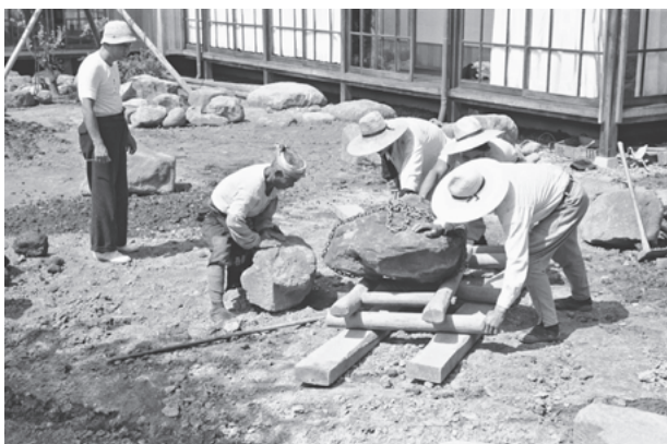
図2 東大寺龍蔵院庭園工事中(橋本聖圓撮影)
