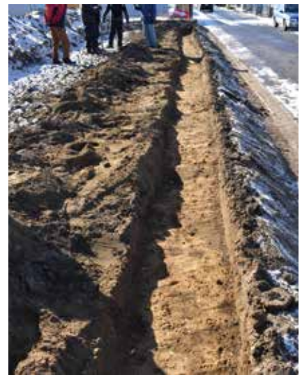
トレンチ 1 (北より)
