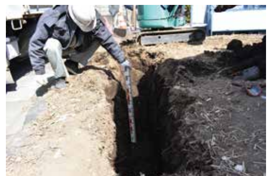
トレンチ (掘削深度)
