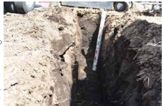
トレンチ (北壁から底部)
