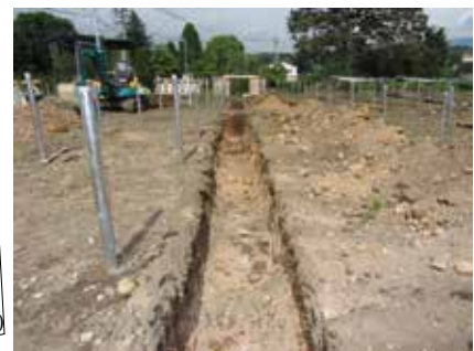
トレンチ5、6付近 (西より)
