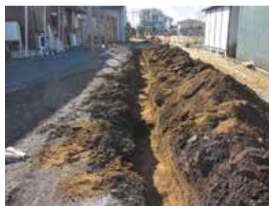
トレンチ 2 (北より)
