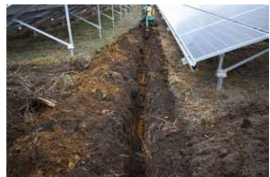
パネル前の浸透側溝
