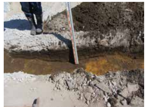
トレンチ1 擁壁抜き取り痕跡
