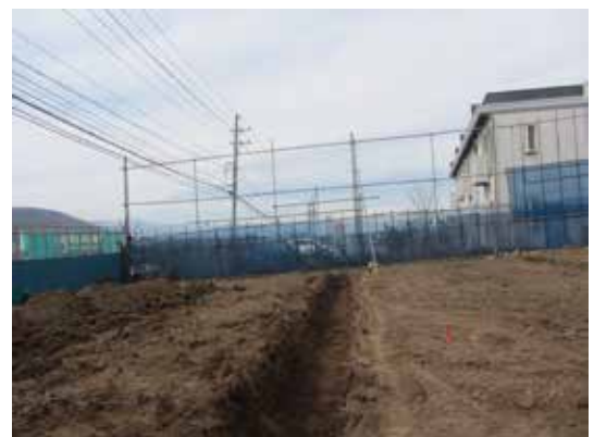
トレンチ 2 (東より)
