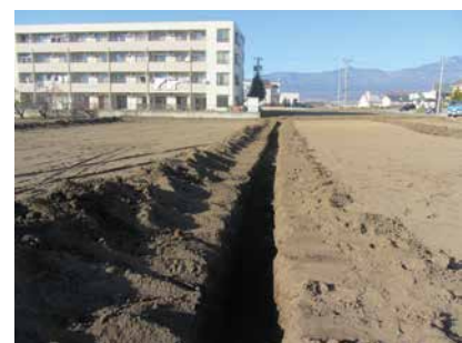
トレンチ 2 (南より)
