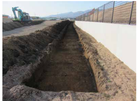
トレンチ10 (南より)
