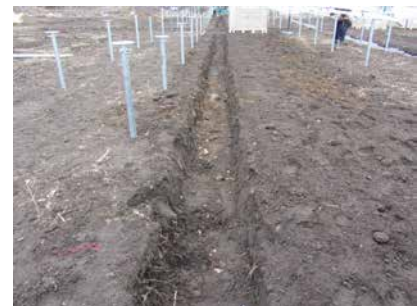
中央部付近浸透側溝
