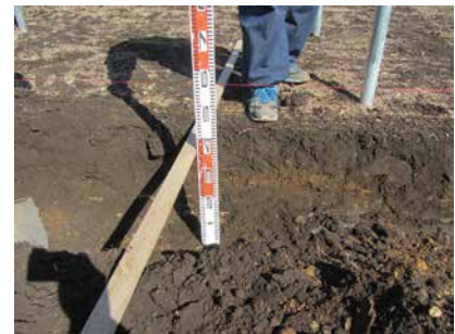
南端浸透側溝断面
