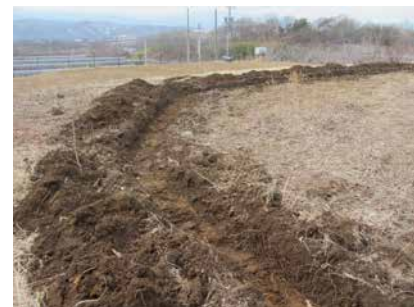
浸透側溝掘削状況①
