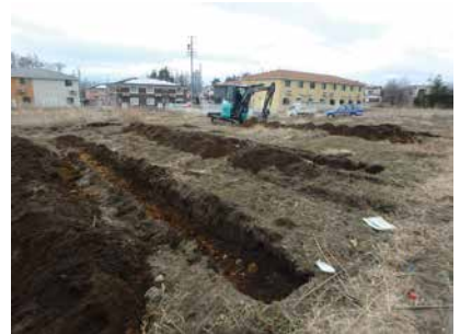
トレンチ 1、2 (北東端より)
