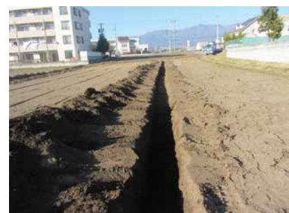
トレンチ 3 (南より)
