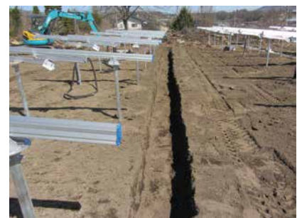
北端浸透側溝
