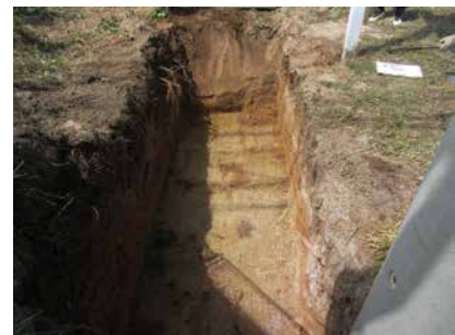
トレンチ全体 (西より)
