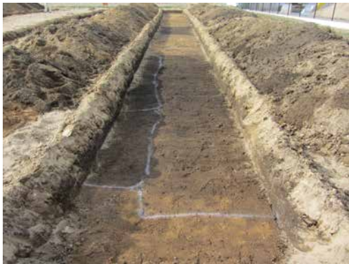
トレンチ7 (南より)
