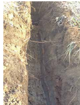
トレンチ (南より)
