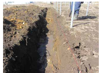
南端浸透側溝掘削状況
