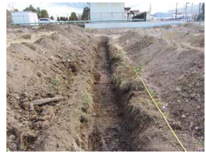
トレンチ 2 (西より)
