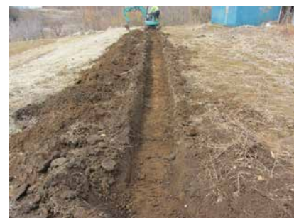
浸透側溝掘削状況②
