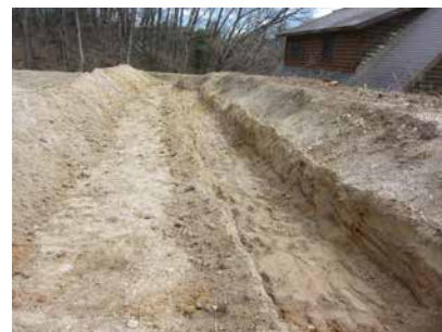
トレンチ (西より)
