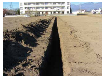
トレンチ 1 (南より)
