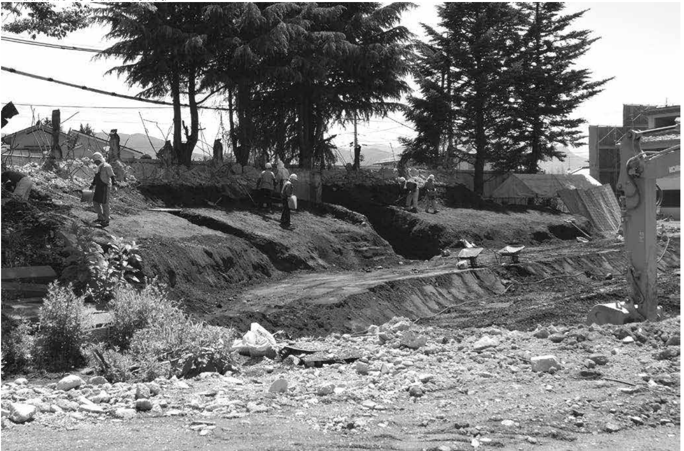
土塁検出状況（旧体育館下）
