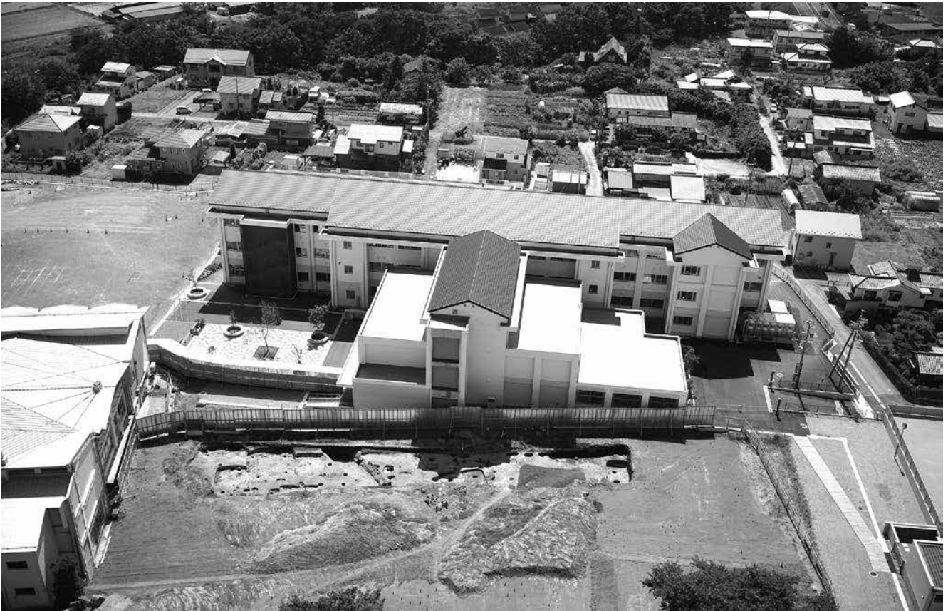
IV区全景（奥の新校舎部分がI区調査範囲）
