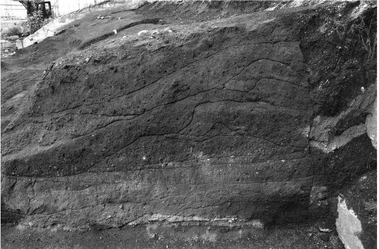
土壘版築状況② (旧体育館下)
