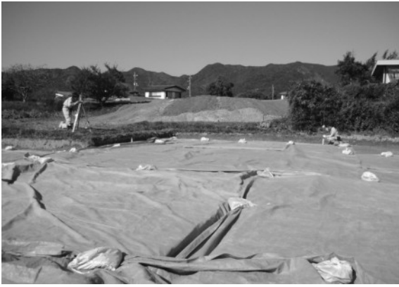
国土座標杭設置
