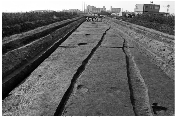
道路側溝 北から
