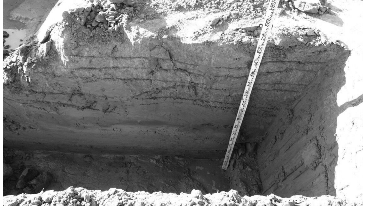
P1 断面状況 東から
