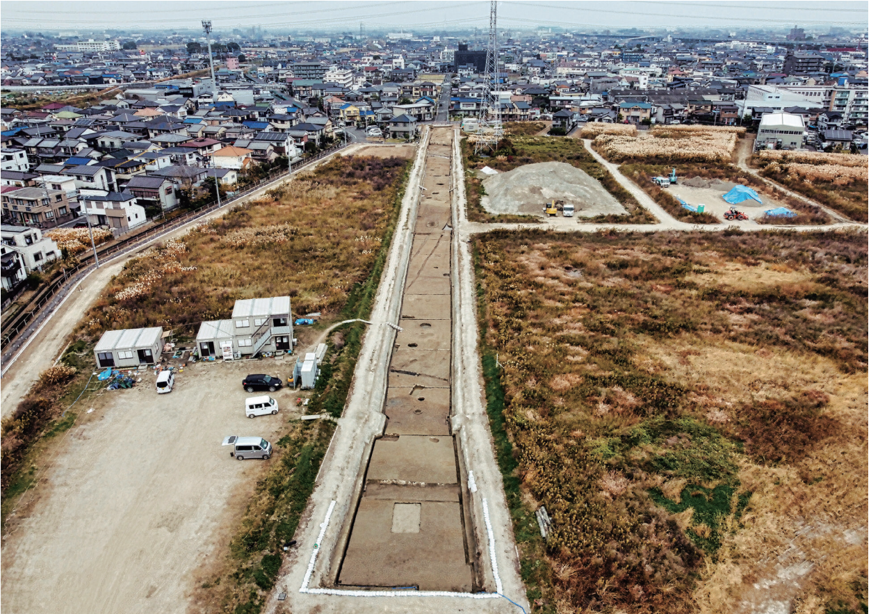
1区全景空撮 南から
