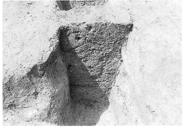
S-04 北側排水溝
