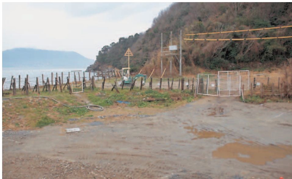
20・21 - 2区調査前状況（東から）
