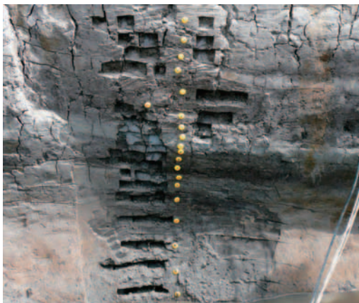
土壌試料採取作業①
