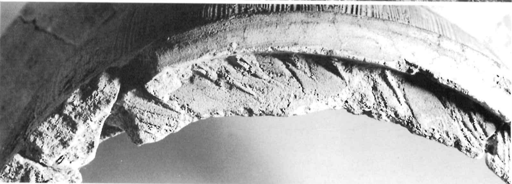
頸部上端の剥離と切込 みに充填された粘土(3)
