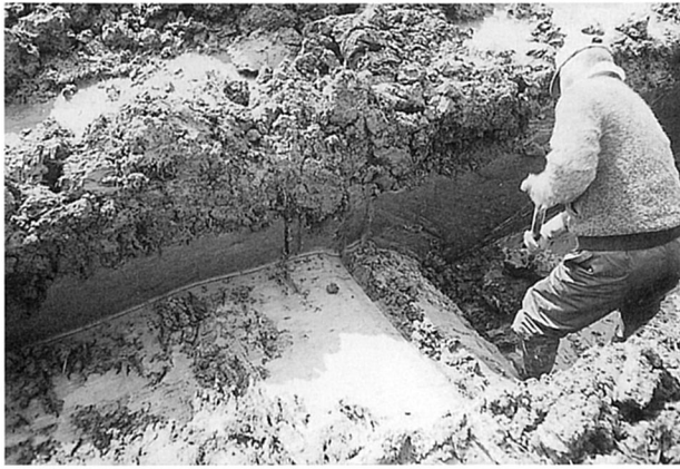
作業風景（10トレンチ）
