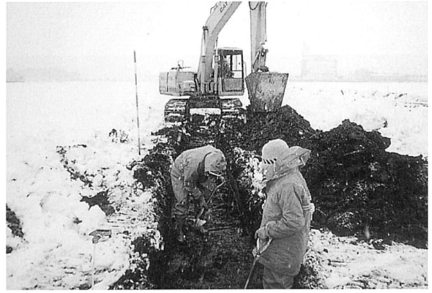
試掘作業風景（1トレンチ）
