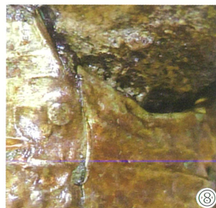
⑧金板の重ね目
