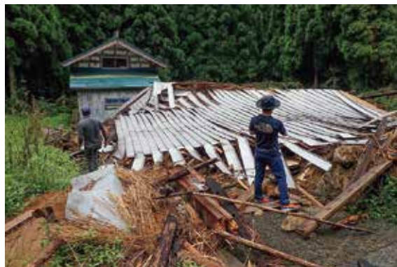
(図65) 被災状況の調査
