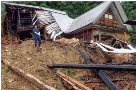
(図64) 主屋の被災状況
